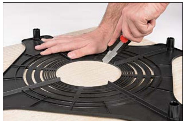
Utilice el SpotClip-Plate como una plantilla para cortar el agujero de fijación en la placa de techo.
